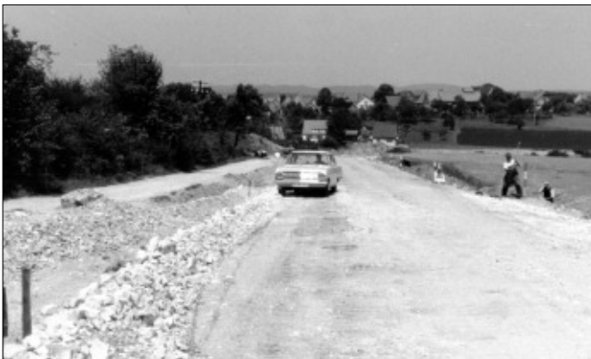
Straßenbau am Hüller Berg 1964; Hans Weidinger Hs. Nr. 1 mit seinem Auto auf der Baustelle; Bild Flurbereinigungsdirektion. 1964
