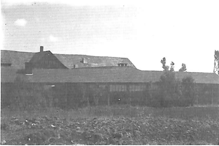
Abb. 28 Betriebsgebäude der Ziegelei in Gollhofen
