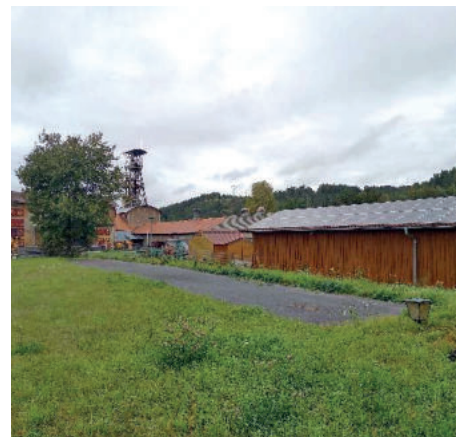
Die „Maffeischächte“ mit der in Betrieb genommenen Photovoltaikanlage; Foto: M. Regn
