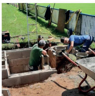
Arbeiten am Schacht für die Bewässerungsanlage, TSV Velden; Foto: N. Röhrich
