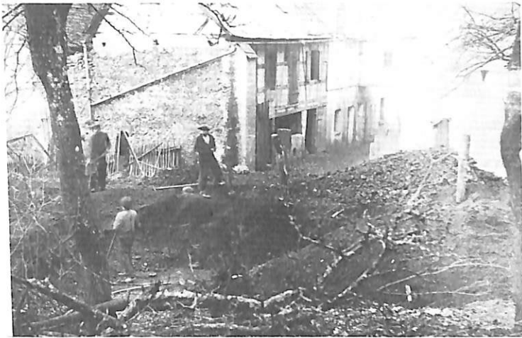
Abbau der Eisenschlacken in Betzenstein Pl.Nr.243 Bild 1 und 2
