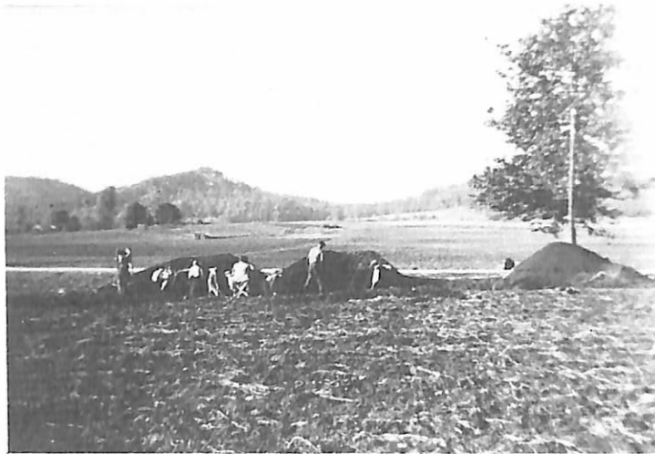
Schlackenabbau auf freien Feldgelände am Hoferanger.
