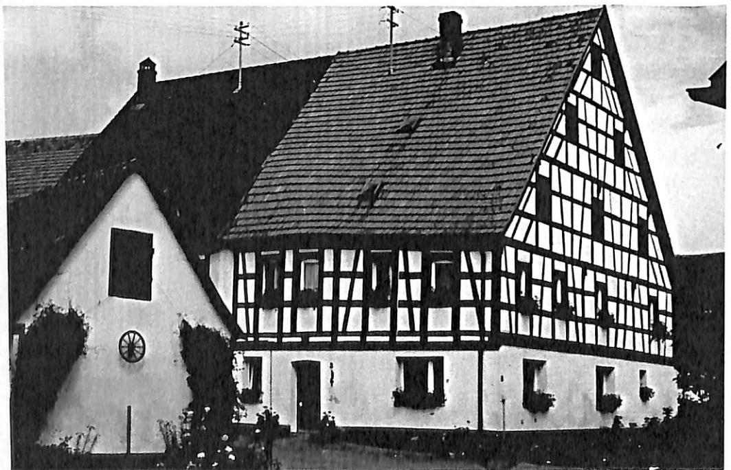
Haus Nr.3 rechts mit dem hellen Dach
