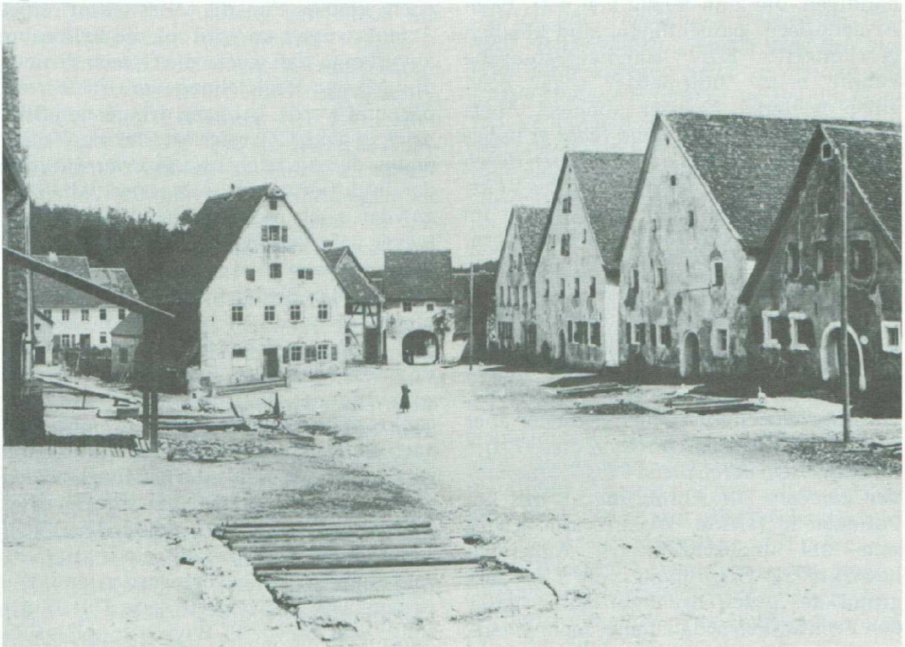
Abb. 10: Betzenstein. Hauptstraße mit Unterem Tor und Brunnenhaus von Süden, um 1914 (mit frdl. Genehmigung der Stadtgeschichtlichen Museen Nürnberg).
