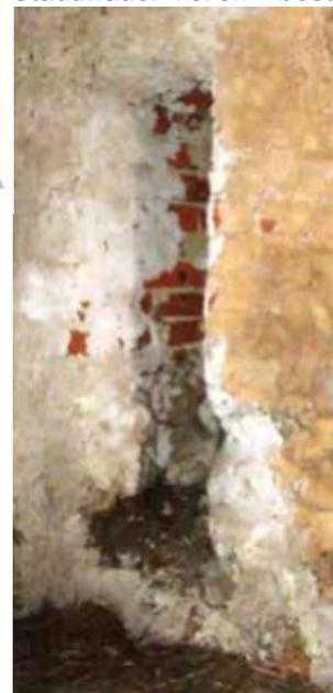
Dachboden, so erkennt man, dass die Balken des Dachbodens auf dem Mauerabsatz des ehemaligen Wehrgangs gelagert sind.
