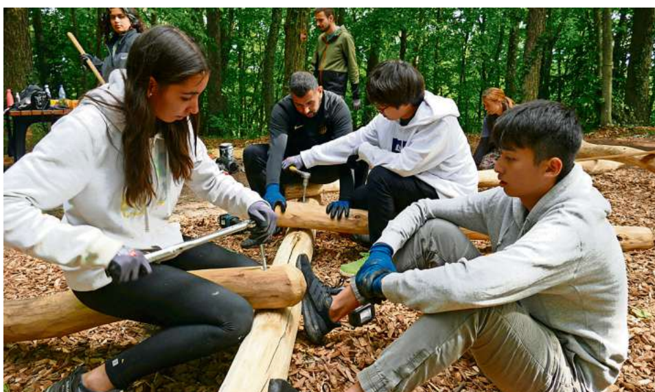
Auf dem Programm stand auch der Bau eines Barfußpfades.
