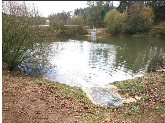
Abbildung 34 Schönungsteich mit Ablaufbauwerk
