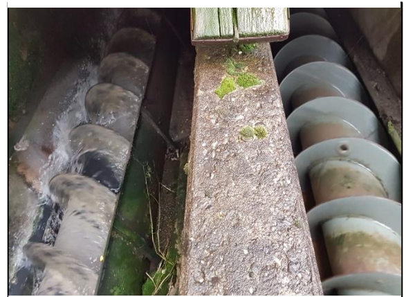
Abbildung 4 Zulaufhebewerk
