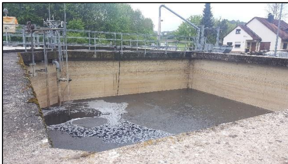
Abbildung 6 Schlammstapelbehälter
