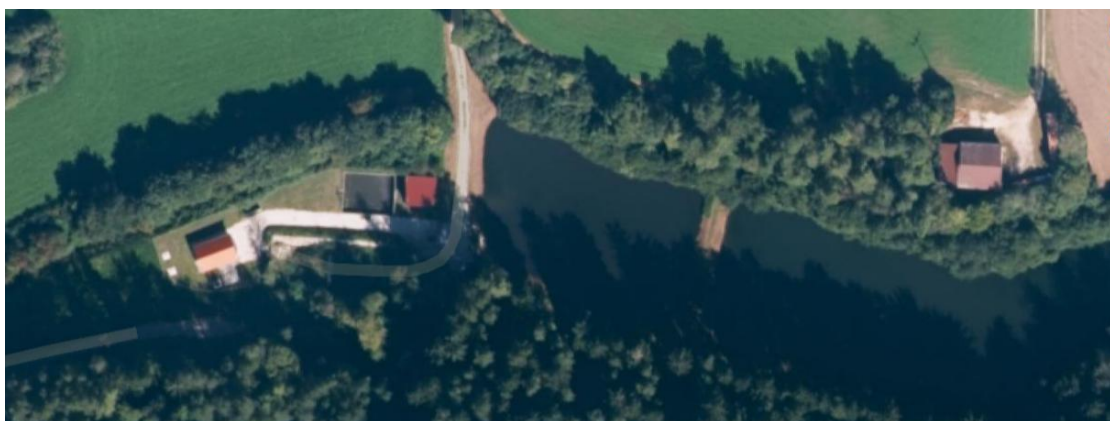
Abbildung 12 Luftbild Bayernatlas Teichkläranlage mit Ausbau RÜB Weidensees Süd und Pumpwerk
